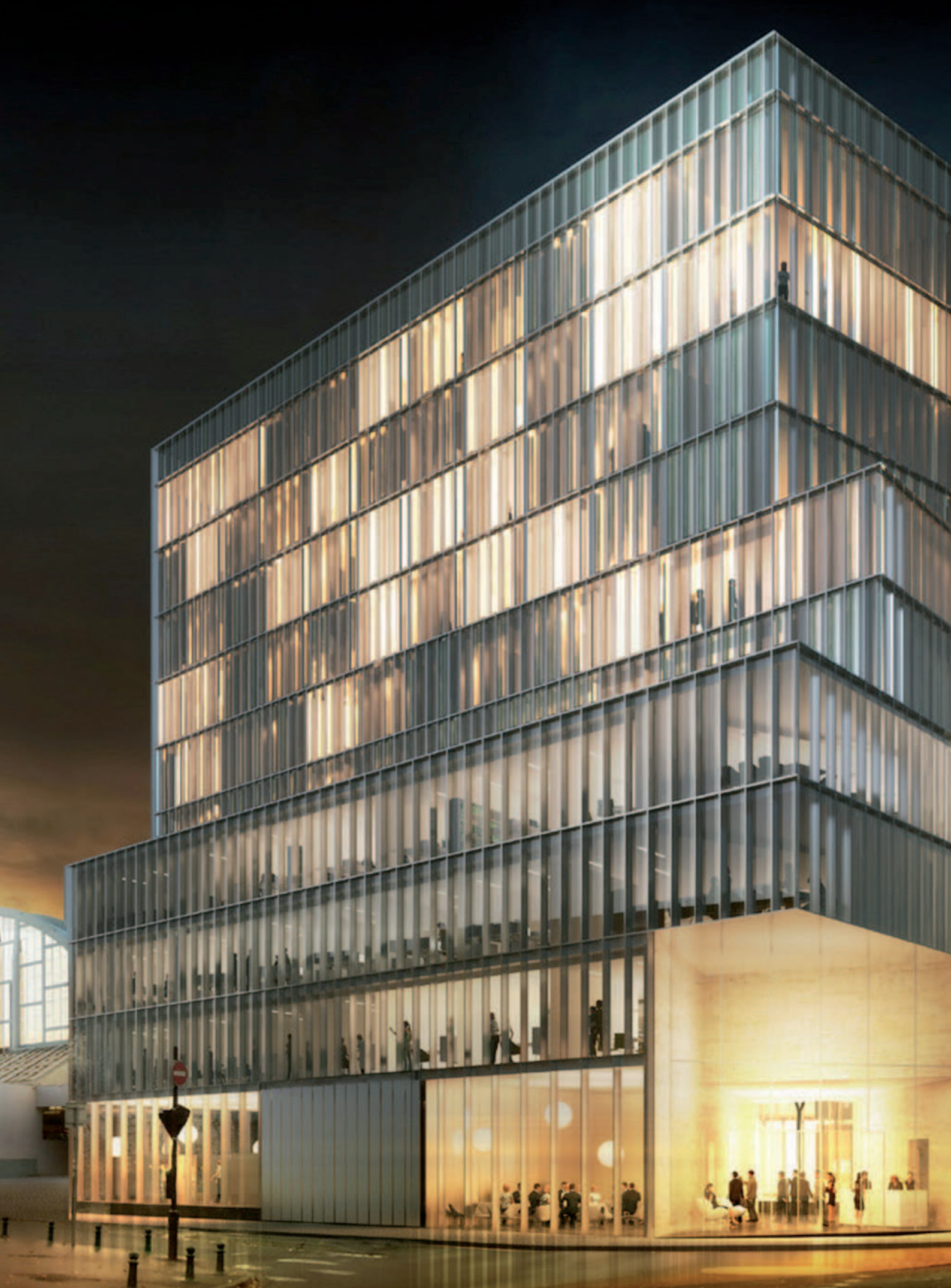
Projet L'Agora, hôtel 4* de 110 chambres à Reims, ouverture en 2017. Construction par ADIM (Groupe Vinci Construction France).
